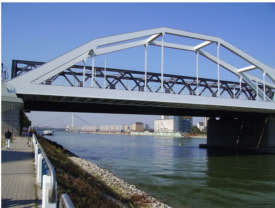
Imagen nº 6: Puente fabricado con acero. Fuente: https://es.wikipedia.org/wiki/Acero Autor: Desconocido. Licencia: Dominio público
