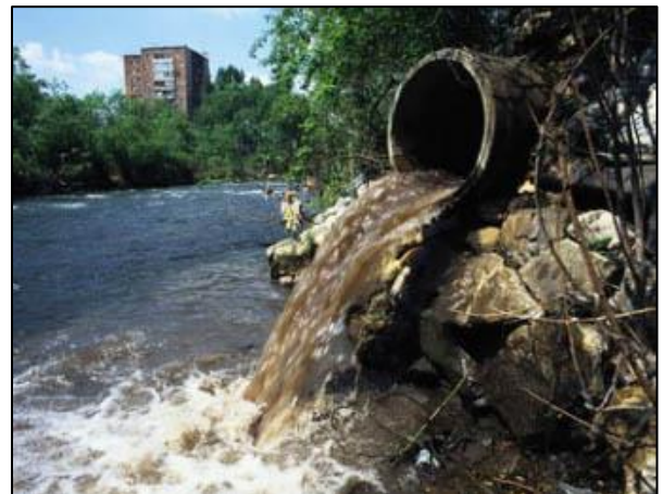
Imagen 8: Vertido de aguas sin depurar a un cauce fluvial.
